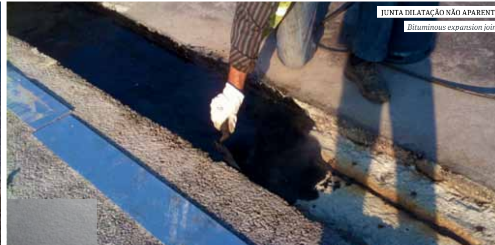
JUNTA DILATAÇÃO NÃO APARENTE Bituminous expansion joint
