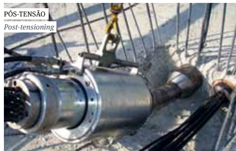
PÓS-TENSÃO Post-tensioning
