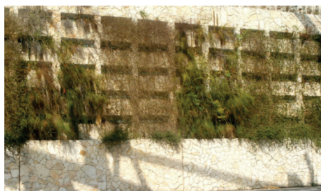
Muro com revestimento em pedra e vegetação natural
