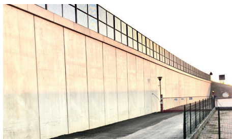
Muro em betão à vista
