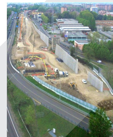
Tangenziale nord Milano Paderno Dugnano (MI) Empreiteiro geral: Grandi Lavori Fincosit S.p.A. 45°33'40.6"N 9°10'27.0"E
