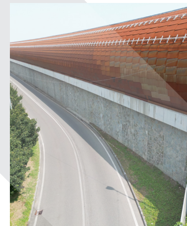
Tangenziale nord Milano Paderno Dugnano (MI) Empreiteiro geral: Grandi Lavori Fincosit S.p.A. 45°33'32.3"N 9°10'04.8"E
